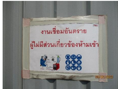
รูปที่ 2-51 การกันเขต และติดป้ายแสดงเขตหวงห้าม บริเวณพื้นที่ที่ทำการเชื่อม
