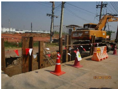
รูปที่ 2-20 การติดตั้งอุปกรณ์ป้องกันดินถล่มบริเวณร่องชุด
