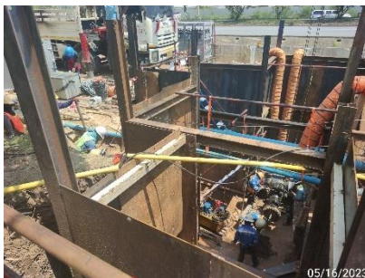
รูปที่ 2-55 การติดตั้งราวเหล็กราวเหล็กและป้ายเตือน บริเวณโดยรอบพื้นที่ดำเนินการ Tie-in
