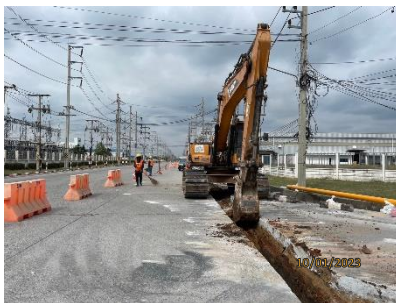
รูปที่ 2-7 การขุดเปิดหน้าดินสำหรับวางท่อเท่านั้น
