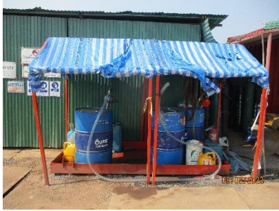
รูปที่ 2-28 ที่รองรับน้ำมัน ถาดรอง และวัสดุดูดซับ
