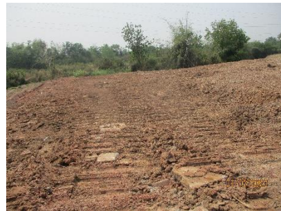
รูปที่ 2-41 การฝังกลบโคลนโซเดียมเบนโทไนท์
