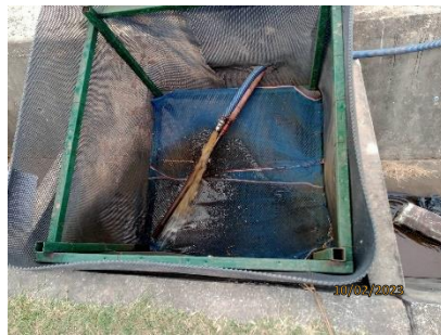
รูปที่ 2-33 การติดตั้งตะแกรงหรือตาข่าย เพื่อดักตะกอนก่อนระบายน้ำทิ้ง
