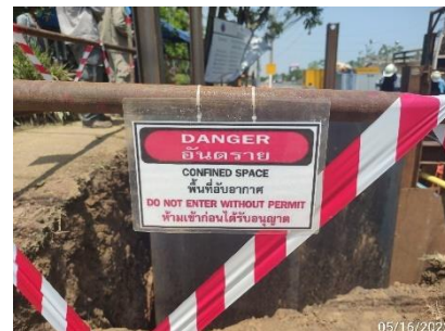
รูปที่ 2-55 การติดตั้งราวเหล็กราวเหล็กและป้ายเตือน บริเวณโดยรอบพื้นที่ดำเนินการ Tie-in
