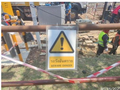
รูปที่ 2-55 การติดตั้งราวเหล็กราวเหล็กและป้ายเตือน บริเวณโดยรอบพื้นที่ดำเนินการ Tie-in
