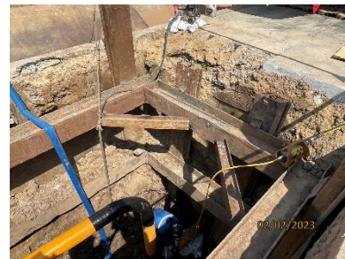
รูปที่ 2-20 การติดตั้งอุปกรณ์ป้องกันดินถล่มบริเวณร่องชุด
