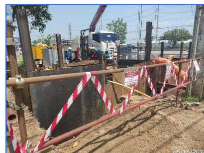
รูปที่ 2-55 การติดตั้งราวเหล็กราวเหล็กและป้ายเตือน บริเวณโดยรอบพื้นที่ดำเนินการ Tie-in
